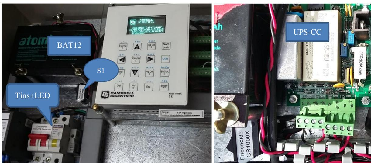
**Figura 7.-** (izq.) Ubicación de llaves de encendido CR1000X (*SI*) y de alimentación de 220V (*Tins*) para sensores OhioSemitronics y UPS-CC, y (der.) placa DIN\_UPS, debajo del Display.
