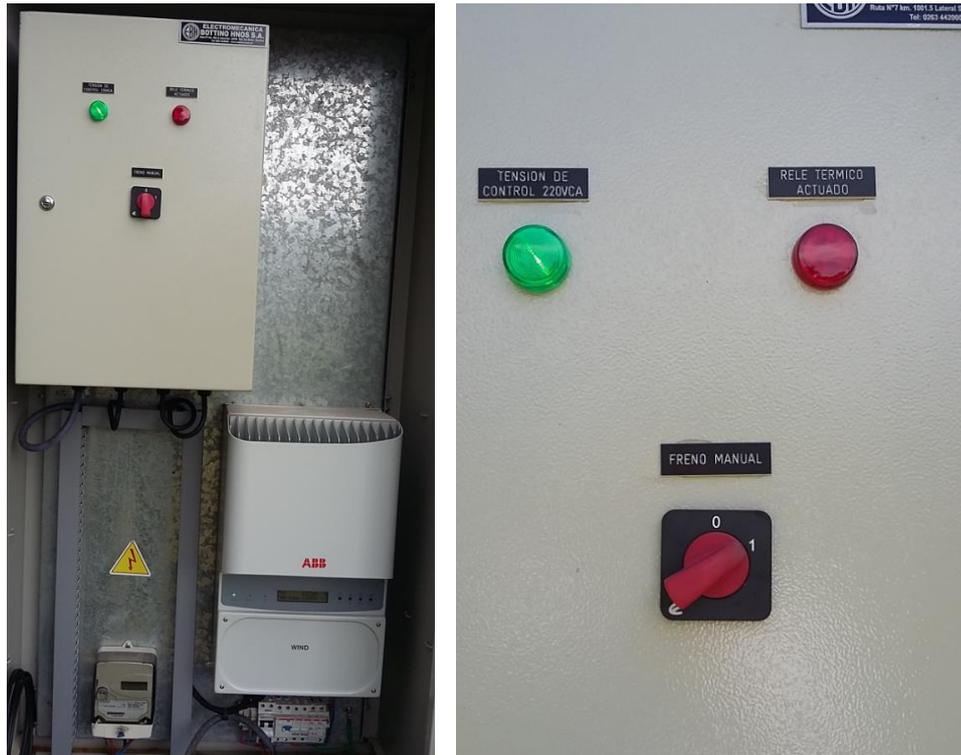
**Figura 19.-** Aspecto que presenta el tablero Wintec (izq.) y detalle de los controles. Normalmente sólo estará encendida la luz verde de red presente, y el Freno Manual en posición 0 para la operación del aerogenerador
