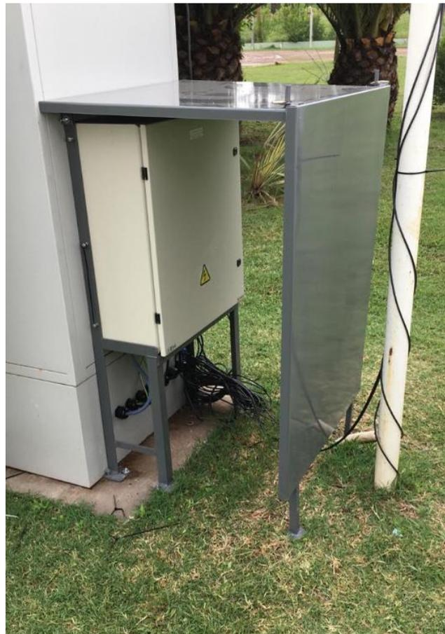
**Figura 18.-** (izq) Vista del sistema instalado, y (der.) protector contra incidencia directa del sol sobre el tablero
