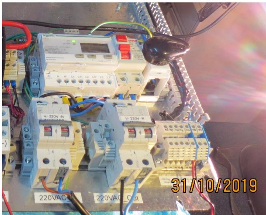
**Figura 12.-** Conexión del Multimetro Schneider y foto del mismo en ensayo.
