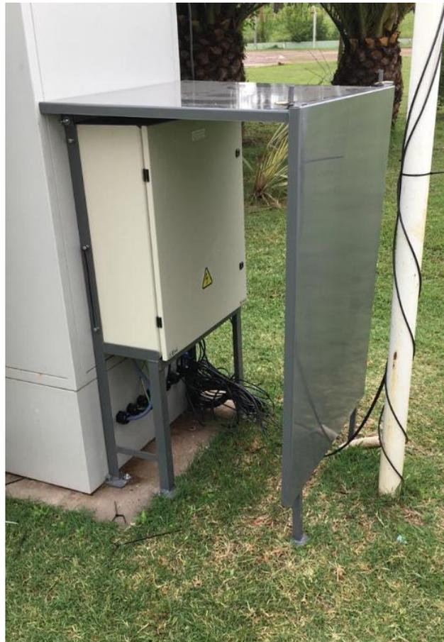
**Figura 34.-** Protector contra incidencia directa del sol sobre el tablero instalado por CELAR
