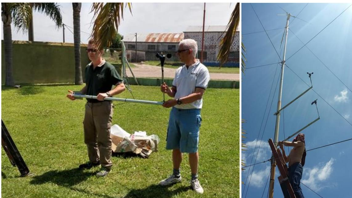
**Figura 26.-** Preparación e instalación de sensores de viento
