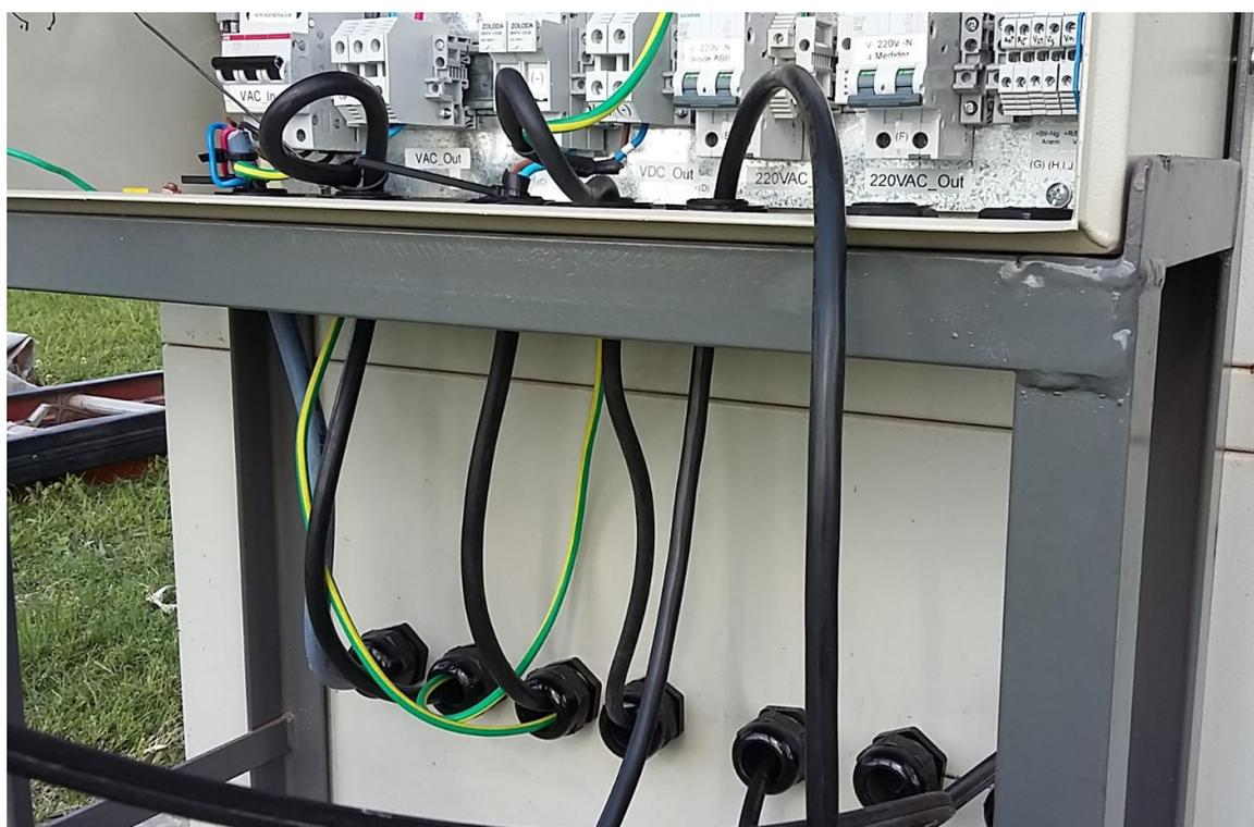
**Figura 28.-** Cableado de Entrada – Salida hacia el Tablero Wintec en proceso
