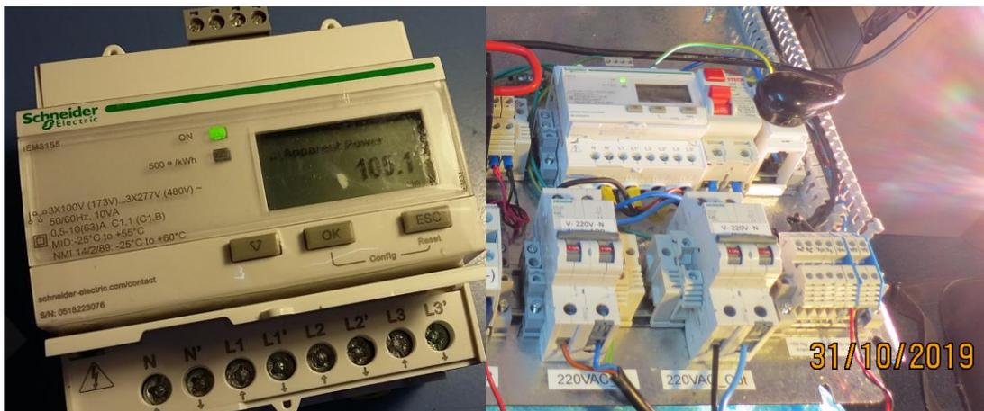
**Figura 21.-** Detalle de los ensayos de la parte de conexión a red / multimetro Schneider
