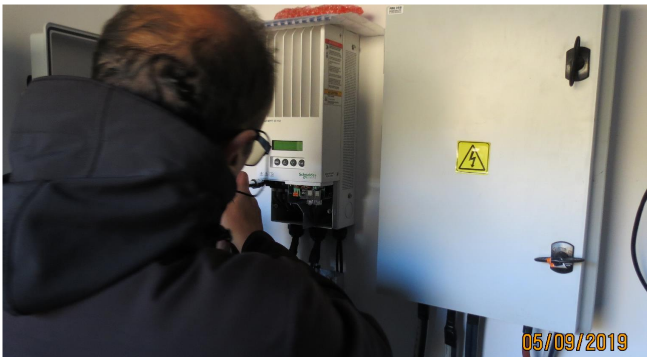
Figura 2.b.13 – Puesto El Zurdo – Control de Torque reguladores
