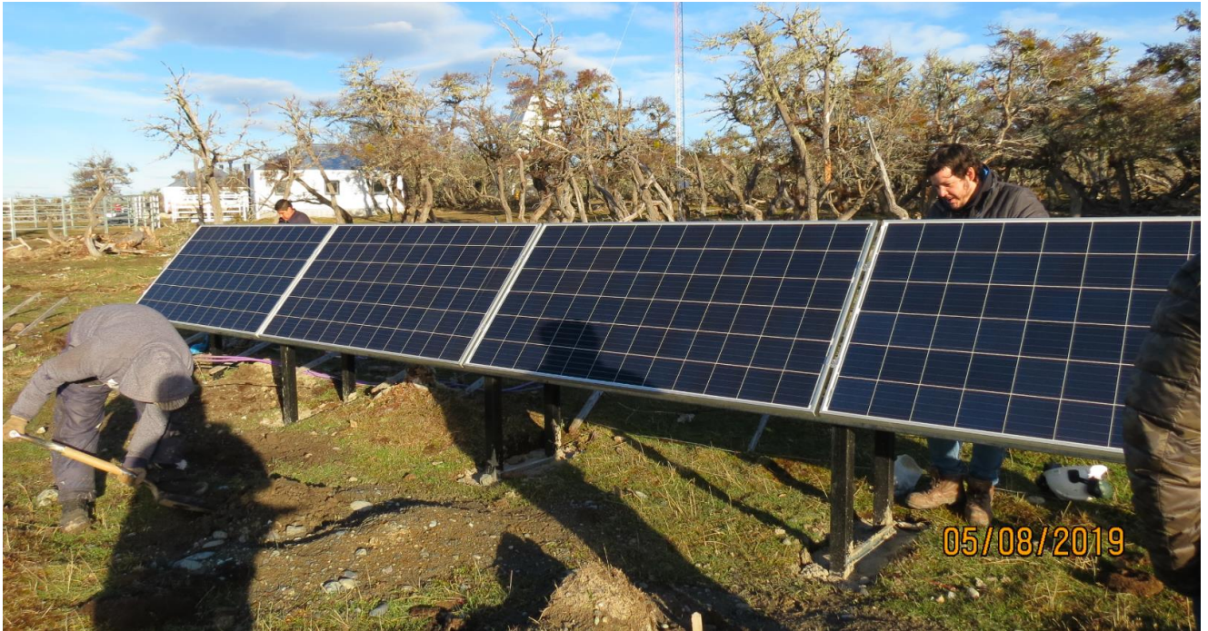
Figura 2.c.3 – Puesto Arteaga – Sistema solar FV en montaje
