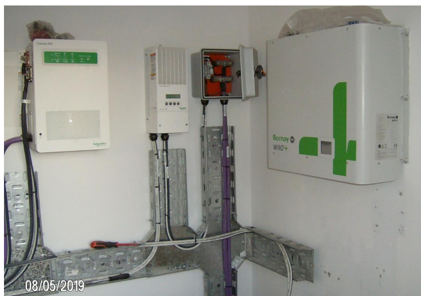
Figura 2.c.2 – Puesto Arteaga – Otra vista del tablero
