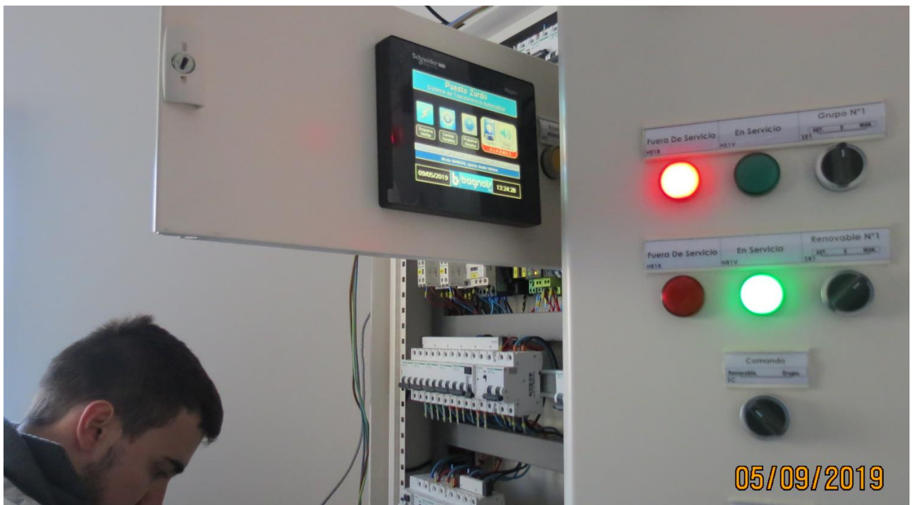
Figura 2.b.15 – Puesto El Zurdo – Puesta en marcha TGBT Ings. Pedulla y Cincotta
