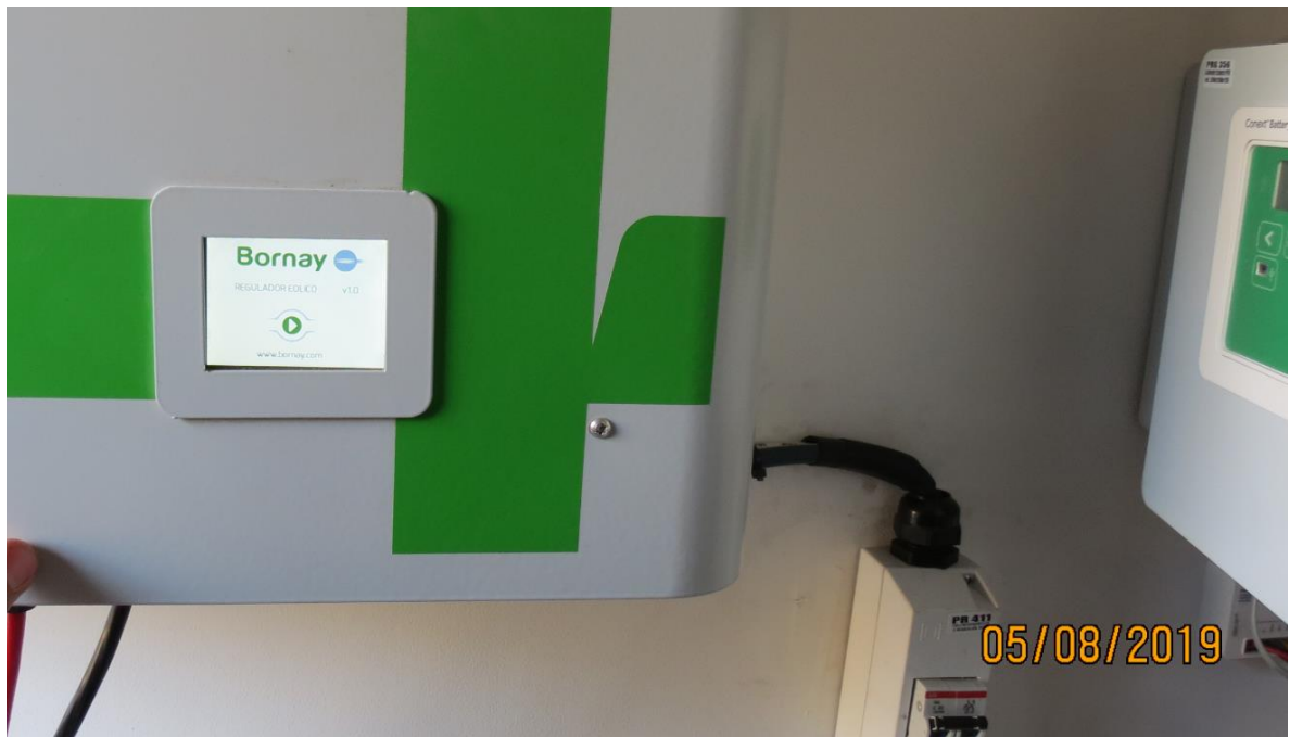
Figura 2.b.9 – Puesto El Zurdo – Conexión regulador Bornay
