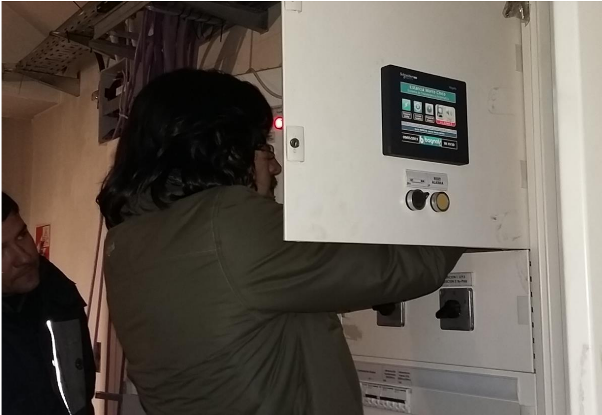
Figura 2.a.22 – Puesta en marcha del TGBT – Casco Morro Chico
