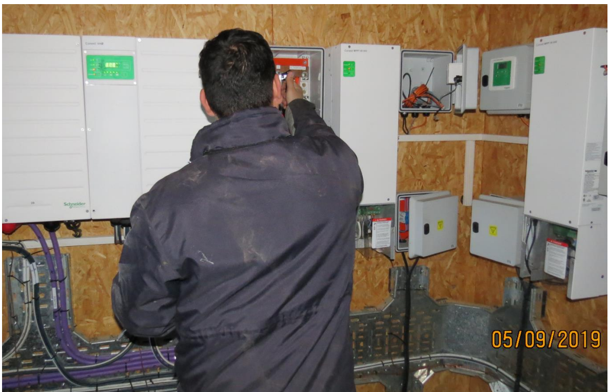
Figura 2.a.15 – Ing. Brito en re-conexión individual de componentes al banco de baterías 9/5/2019
