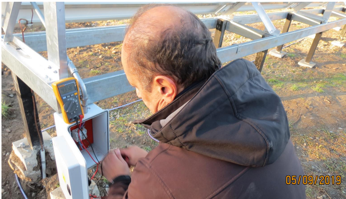
Figura 2.a.13 – Verificación de tensión bancos de paneles solares ( 435 Vcc) por Ing. D'Aloia / Intermepro el 9/5/2019
