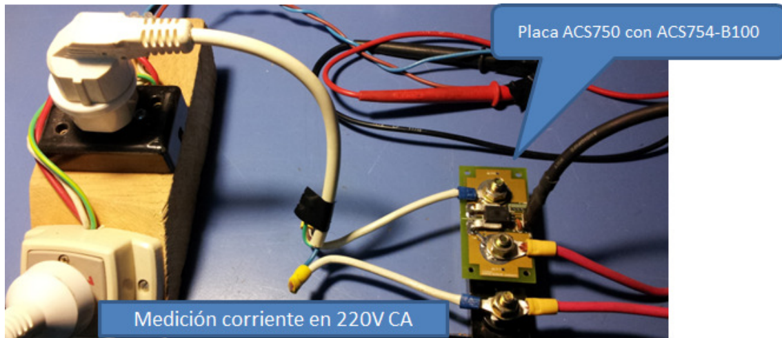
Figura 4.9 – Detalle de conexión - Ensayo de Placa ACS750 con ACS754 B-100 (bidireccional) sobre 230 Vac (2015)
